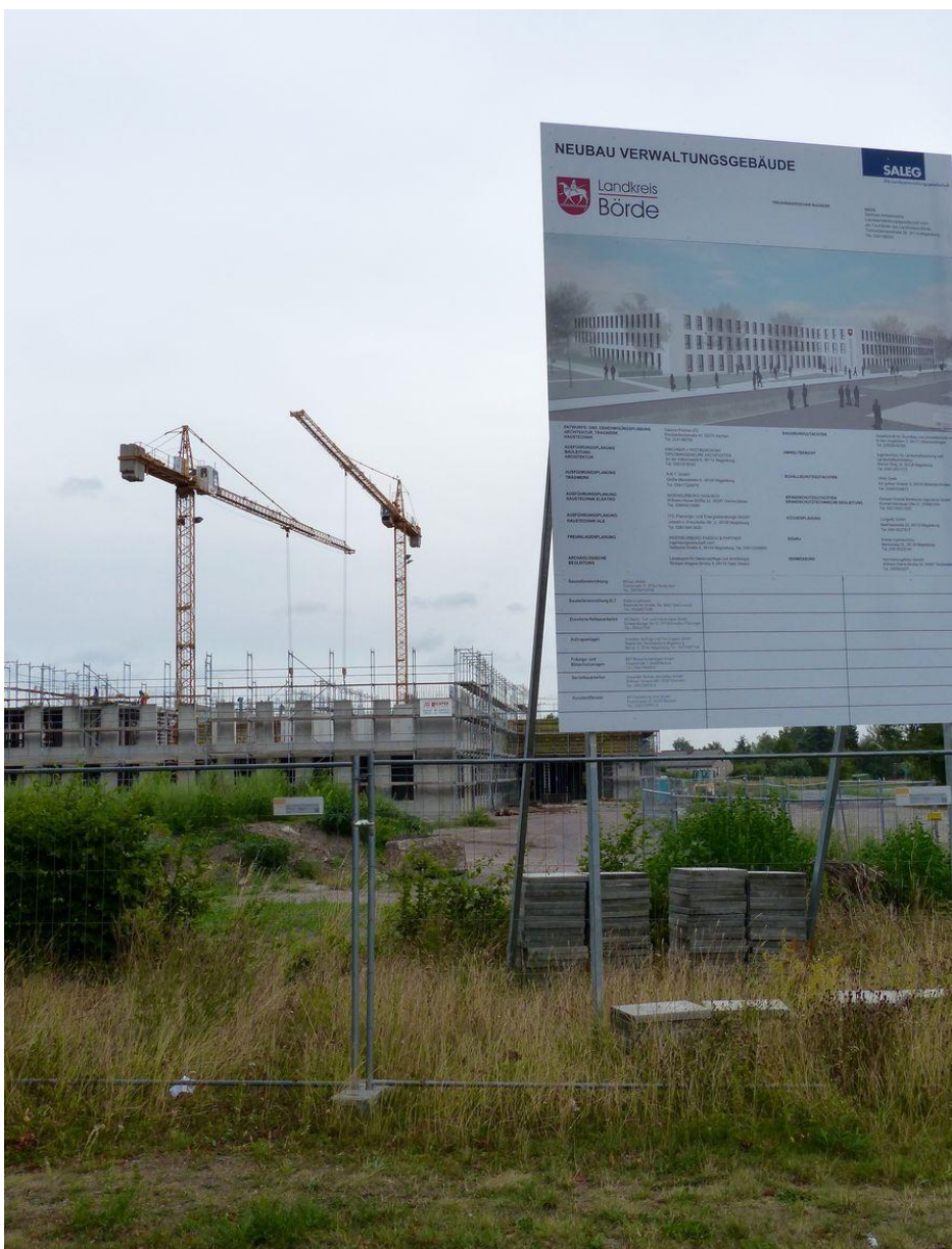
So ist der Baustelleneinblick für Passanten der Bornschen Straße. Auf dem Baustellenschild kann man erkennen, was hier entsteht. Foto Uwe Baumgart
