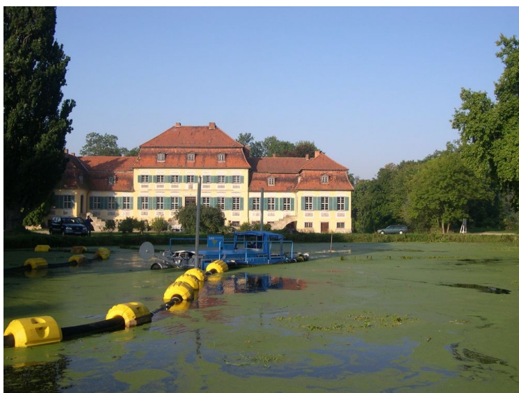
Entschlammung der Pferdeschwemme im Gutspark Seggerde
