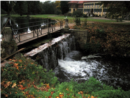
Das Mühlenwehr im Gutspark Seggerde
